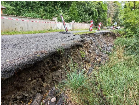
Figure 4 : Glissement du talus en contre-bas de la Rue du Canal
