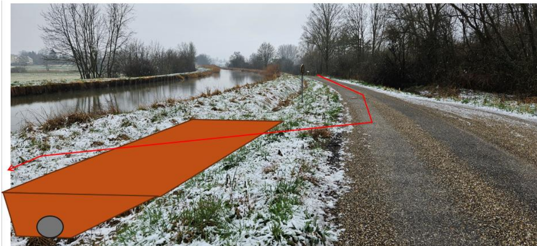
Figure 19 : Passage à créer sur le chemin de halage en pied de talus
