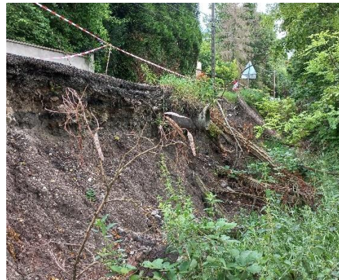
Figure 4 : Glissement du talus en contre-bas de la Rue du Canal
